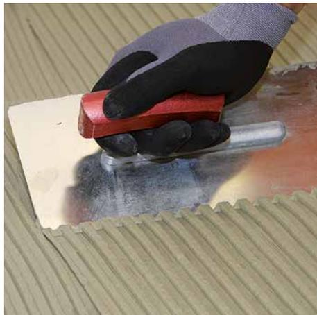
**2** Mit einem flexiblen Fliesenkleber (z.B. Racofix® Multi-Flexkleber, Racofix® Super-Flexkleber S1) zunächst eine Kontaktschicht, anschließend das Kammbett (6er oder 8er Zahnung) aufziehen.
