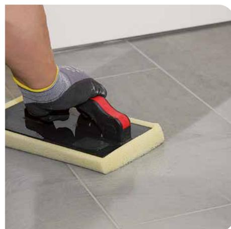
**6** Anschließend den Belag mit sauberem Schwambrett oder Handschwamm diagonal zum Fugenverlauf sauberwaschen. Nach Trocknung des Fugenmörtels den verbliebenen Mörtelschleier mit einem trockenen, sauberen Tuch entfernen.
