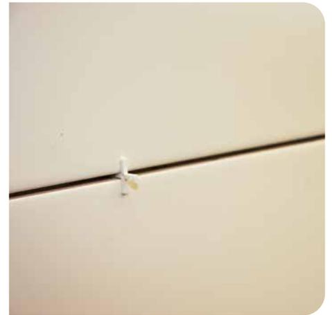
**6** Als Orientierung für gleichmäßige Fugenbreiten können Fugenkreuze verwendet werden. Vor dem Verfugen sind diese wieder zu entnehmen.
