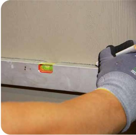
**1** Die zu verfliesende Fläche zunächst genau vermessen und einteilen, gegebenenfalls eine Hilfslinie ziehen.
