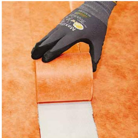
**5** Racofix® RF-100 Flex-Dichtband einlegen und mit der Kelle andrücken.
