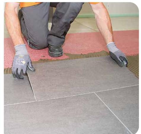
**6** Anschließend mit einer passender Zahnkelle das Kammbett aufziehen und die Platte in das Kleberbett einlegen.
