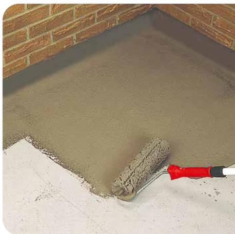
**4** Die erste Abdichtungsschicht wird z.B. mittels Lammfellrolle aufgetragen (alternativ spachteln oder streichen). Dabei wird das Dichtband nahtlos in die Abdichtungsschicht eingebunden.
