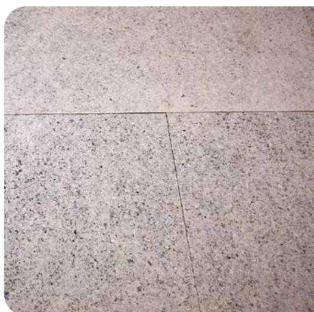
**4** Die Verlegung der Platten erfolgt vollflächig und bündig nebeneinander (Stoß an Stoß). Stöße nebeneinander liegender Platten werden versetzt verlegt.
