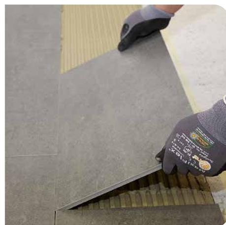
**6** Die anschließende Fliesenverlegung erfolgt nach Begehbarkeit der Racofix® Entkopplungs- und Dämmplatte (siehe Produktinformation des verwendeten Racofix® Fliesenklebers, z.B. Racofix® Multi-Flexkleber, Racofix® Super-Flexkleber S1).
