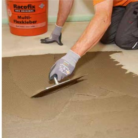
**2** Mit einem flexiblen Fliesenkleber (z.B. Racofix® Multi-Flexkleber, Racofix® Super-Flexkleber S1) zunächst eine Kontaktschicht aufbringen und anschließend das Kammbett (4er Zahnung) aufziehen.
