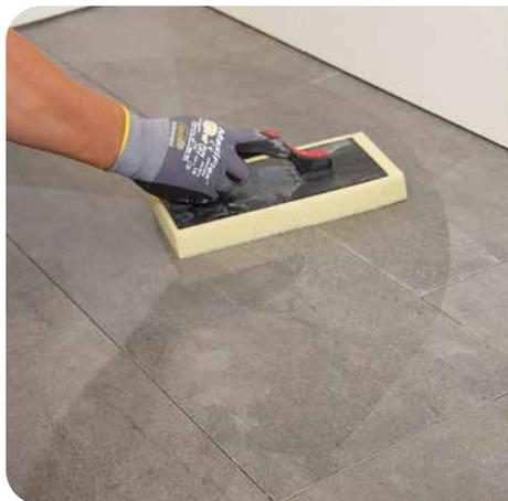
**1** Den Belag zunächst mit einem feuchten Schwamm leicht vornässen. Dies erleichtert die nachfolgende Verfugung (insbesondere bei profilierten, rauen, unglasierten, unpolierten und offenen Oberflächen).
