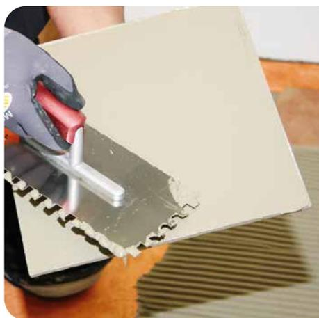
**4** Racofix® Fliesenkleber, wie auf dem Foto gezeigt, zusätzlich auf die Plattenrückseite aufziehen (Buttering-Floating-Verfahren).
