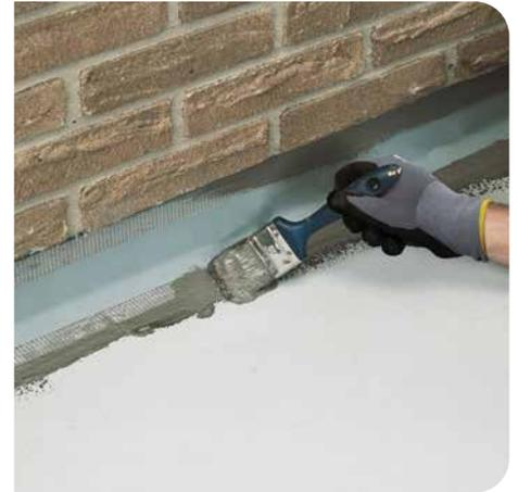
**3** Racofix® Dichtband im Übergang zwischen Wand und Boden mit Racofix® Multi-Dicht einbetten. Für Eckbereiche und Wasseranschlüsse empfehlen wir Racofix® Dichtecken und Dichtmanschetten.
