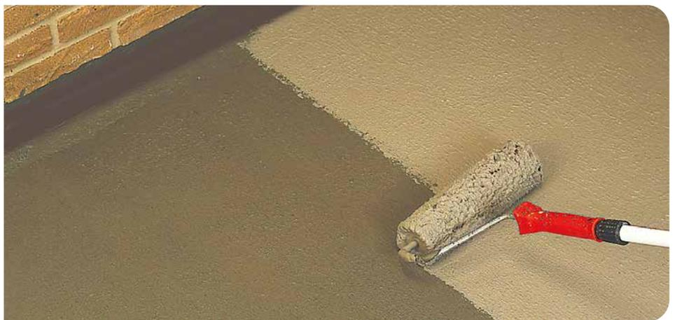
**5** Nach Trocknung der ersten Schicht erfolgt ein zweiter Auftrag. Die Gesamtschichtdicke beider Abdichtungsschichten muss nach Trocknung mind. 2 mm betragen. Im Übergang zur Wand wird die Abdichtung bis auf Sockelhöhe hochgezogen.
