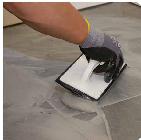
**3** Die zu verfugende Fläche mit einer Fugscheibe diagonal zum Fugenverlauf einschlämmen. Den Fugenmörtel dabei dicht und tief einbringen und die Fuge vollständig füllen.
