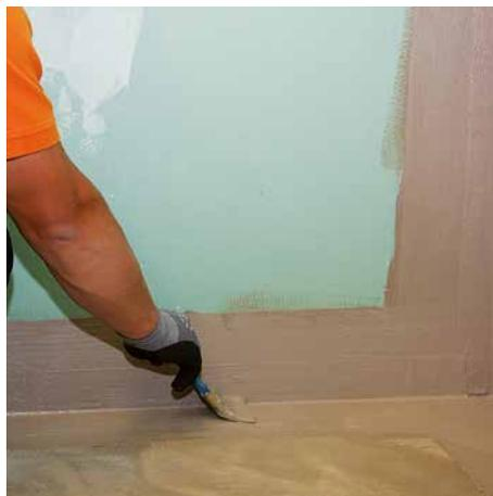
**2** Anschließend Racofix® Dichtband und Dichtecken satt in die Abdichtung aus Racofix® Universal-Montagekleber oder Racofix® WaterBlock einbetten.
