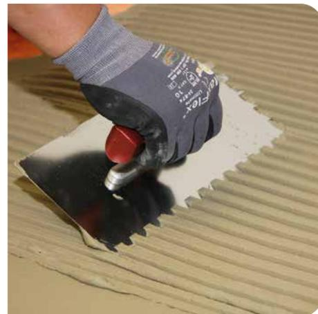
**3** Anschließend mit passender Zahnkelle das Kammbett aufziehen (Winkel 45°–60°). Nicht mehr Fliesenkleber aufziehen, als innerhalb der klebeffenen Zeit mit Fliesen belegt werden kann.
