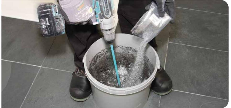
**2** Racofix® Multi-Flexfuge Plus in das vorgelegte Leitungswasser zudosieren und klumpenfrei maschinell anmischen. Eine Reifezeit von 3–5 Minuten ist nach dem ersten Mischvorgang einzuhalten.
