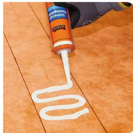
**3** Racofix® Universal-Montagekleber im Stoßbereich auftragen (Alternativ kann Racofix® WaterBlock zur wasserdichten Verklebung der Stöße verwendet werden) ...
