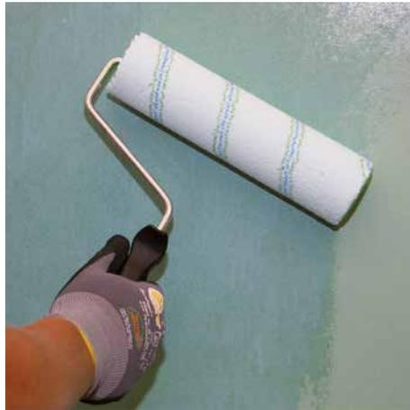
Racofix® Grundierung mit Lammfellrolle, Pinsel oder Quast vollsatt auftragen.
