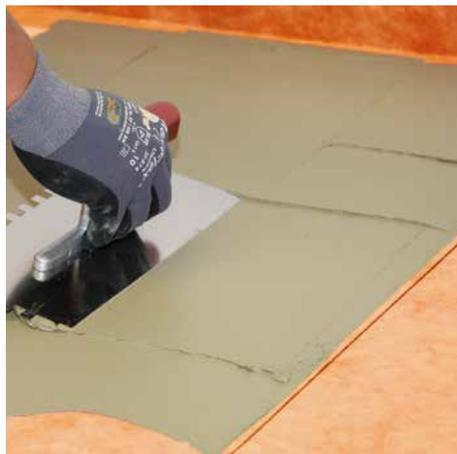
**2** Mit der glatten Seite der Kelle unter Druck eine Kontaktschicht aufziehen.
