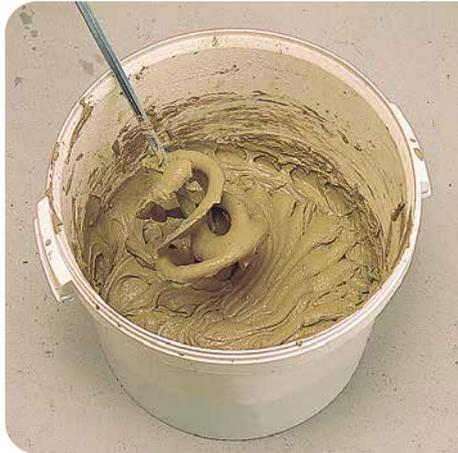
**1** Die komplette Menge Racofix® Multi-Dicht Flüssigkomponente B in einem Eimer vorgeben und die Pulverkomponente A hinzugeben. Mittels Ruhrquirl klumpenfrei anmischen und nach einer Reifezeit von ca. 5 Minuten erneut durchrühren.
