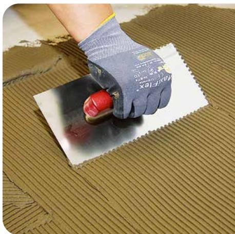
**1** Mit Racofix® Multi-Flexkleber schnell zunächst eine Kontaktschicht, anschließend das Kammbett (3er oder 4er Zahnung) aufziehen.
