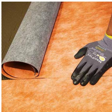
**2** Racofix® RF-100 Flex-Dichtbahn innerhalb der klebeoffenen Zeit einlegen und mit der Kelle gut andrücken. Die Verlegung erfolgt bündig nebeneinander (Stoß an Stoß).
