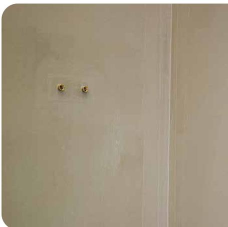
**4** Zur flächigen Abdichtung wird Racofix® Flüssig-Abdichtung mit einer Lammfellrolle oder Glättkelle satt und porenfrei aufgetragen. Dabei werden Bänder und Formteile vollflächig überarbeitet.
