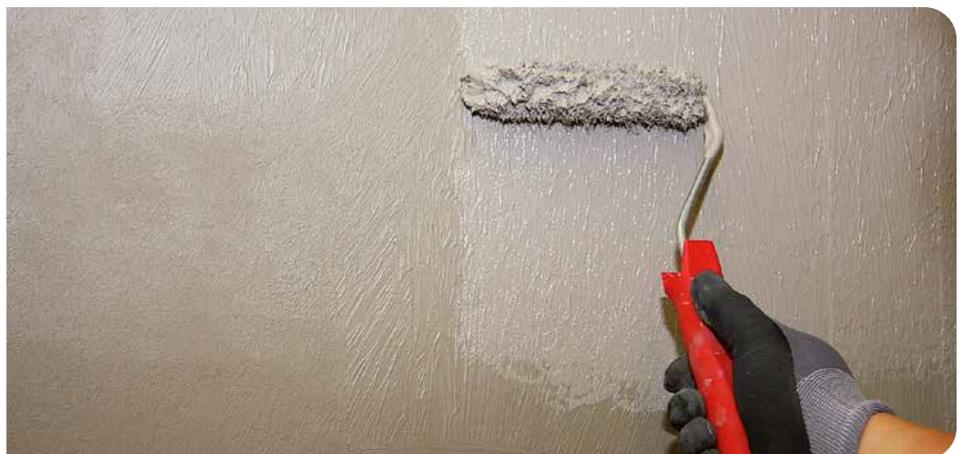
**5** Nach Trocknung der ersten Schicht erfolgt ein zweiter Auftrag. Die Gesamtschichtdicke beider Abdichtungsschichten muss nach Trocknung mind. 0,5 mm betragen.
