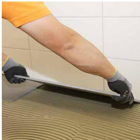
**8** Die Verlegung am Boden erfolgt analog zur Verlegung an Wandflächen. Im Übergang zwischen Wand und Boden ist die Bodenfliese unter die Wandfliese zu schieben.
