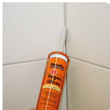
**3** Racofix® Fugen-Silicon möglichst gleichmäßig mit einer Handspritze in die Fuge einbringen.
