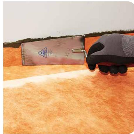
**6** Im Sockelbereich Racofix® Multi-Flexkleber schnell aufbringen, im Grenzbereich zwischen Flexkleber und Abdichtungsbahn Racofix® Universal-Montagekleber (oder Racofix® WaterBlock) aufziehen. Racofix® RF-100 Flex-Dichtband einlegen und gut andrücken.
