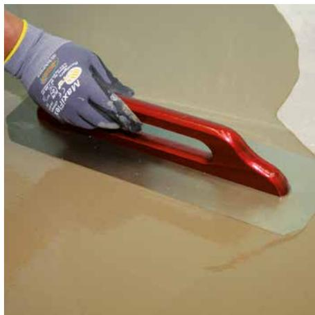
... und mit einer Glättkelle verteilen. Racofix® RF 7-Fließspachtel bzw. Racofix® Nivelliermasse verlaufen selbstständig zu einer ebenen, ansatzfreien Fläche.
