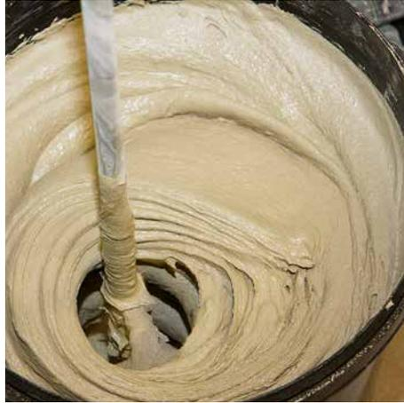
**2** Die auf dem Gebinde angegebene Menge Wasser in einen Eimer vorgeben und das Trockenpulver hinzugeben. Mittels Rührquirl klumpenfrei anmischen und nach einer Reifezeit von ca. 5 Minuten erneut durchrühren.
