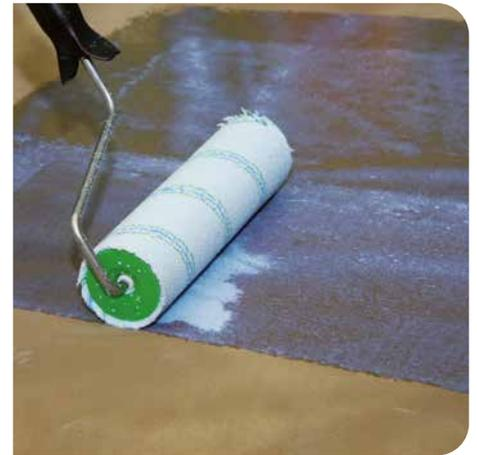
Bei extrem saugfähigen Untergründen kann Racofix® Grundierung mit Wasser verdünnt werden.
