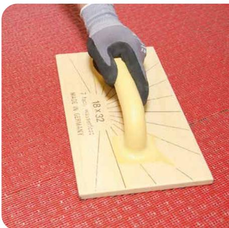
**4** Die Racofix® Entkopplungsmatte plus mit einem geeigneten Werkzeug (z.B. mit einer Holz-scheibe) gut andrücken.
