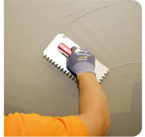
**3** Mit der glatten Seite der Kelle zunächst unter Druck eine Kontaktschicht aufziehen.
