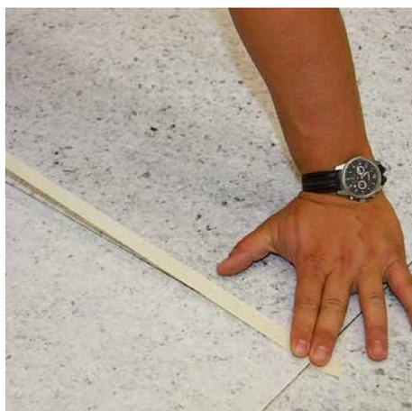
**5** Bei der Verwendung von Racofix® Entkopplungs- und Dämmplatten als Trittschalldämmung die Stoßbereiche der verlegten Platten mit Klebeband (z.B. Tesakrepp) überkleben.
