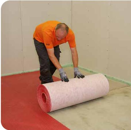
**1** Zunächst den Raum genau vermessen und die Racofix® Entkopplungsmatte plus lose ausrollen. Anschließend mit einem Messer auf die benötigte Größe zurechtschneiden und den erforderlichen Randabstand einhalten.
