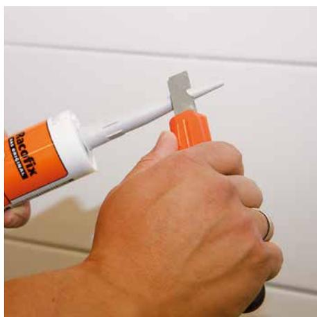
**2** Die Kartuschenspitze zunächst glatt abschneiden, die Düse aufschrauben und diese entsprechend der Fugenbreite schräg abschneiden.
