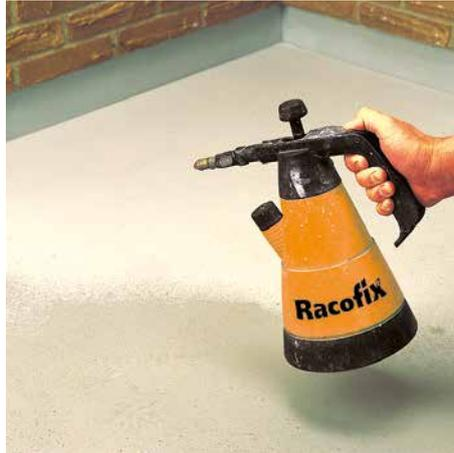
**2** Je nach Untergrund, diesen vor dem Auftrag von Racofix® Multi-Dicht mit Wasser vornässen oder grundieren.
