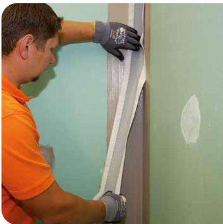
**1** Zunächst Racofix® Universal-Montagekleber oder Racofix® WaterBlock im Eckbereich sowie dem Übergang zwischen Wand- und Bodenflächen auftragen, Racofix® Dichtband bzw. Racofix® Dichtecken einlegen und mit der Kelle fest andrücken.
